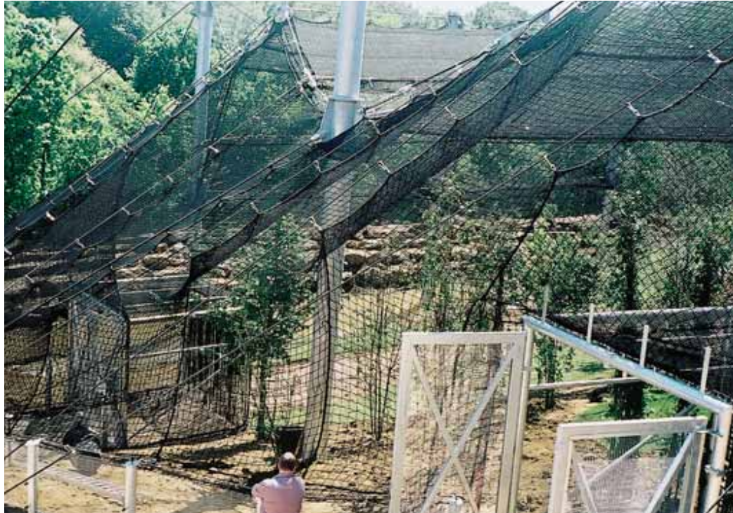
Installation réalisée par Huck-Torimex, Parc des Oiseaux Mundo Verde à Landgraaf, Pays-Bas
