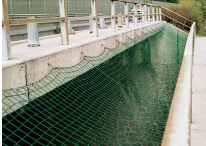
Filet de sécurité sur un pont
