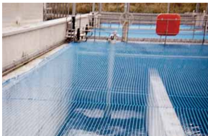
Filet de sécurité sur un bassin d'épuration
