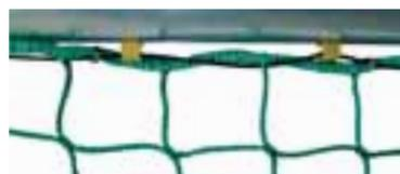
Montage des filets par câble acier gainé PA
