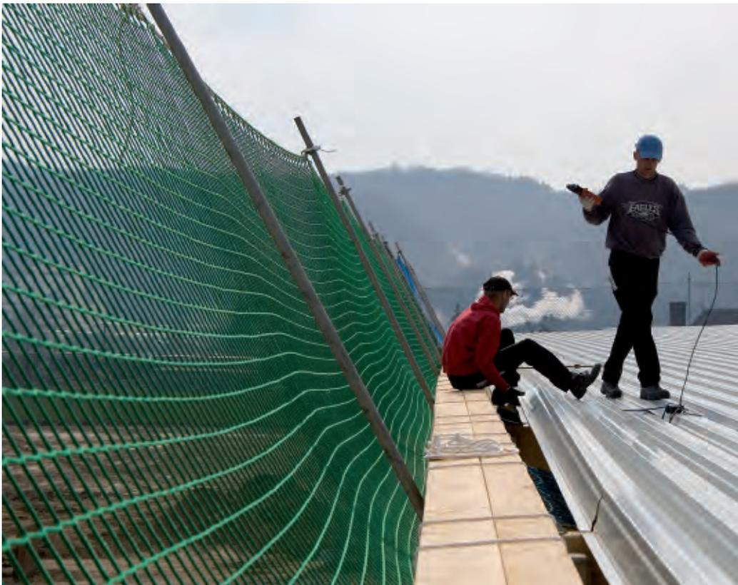
Les systèmes de support que nous proposons, en association avec les filets conformes à la norme NF EN 1263-1, type S, peuvent rester en place et remplir leur rôle de protecteur contre les chutes lors des travaux en toiture après la couverture du bâtiment.
