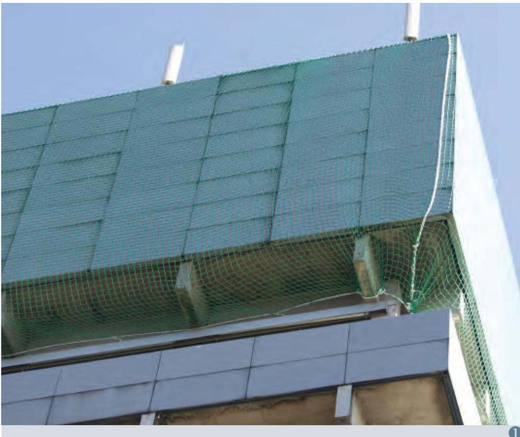
① Un bâtiment de l'université de Giessen est sécurisé par un filet anti-chute. Le filet, destiné à retenir des plaques à la fixation douteuse, reste très discret.
