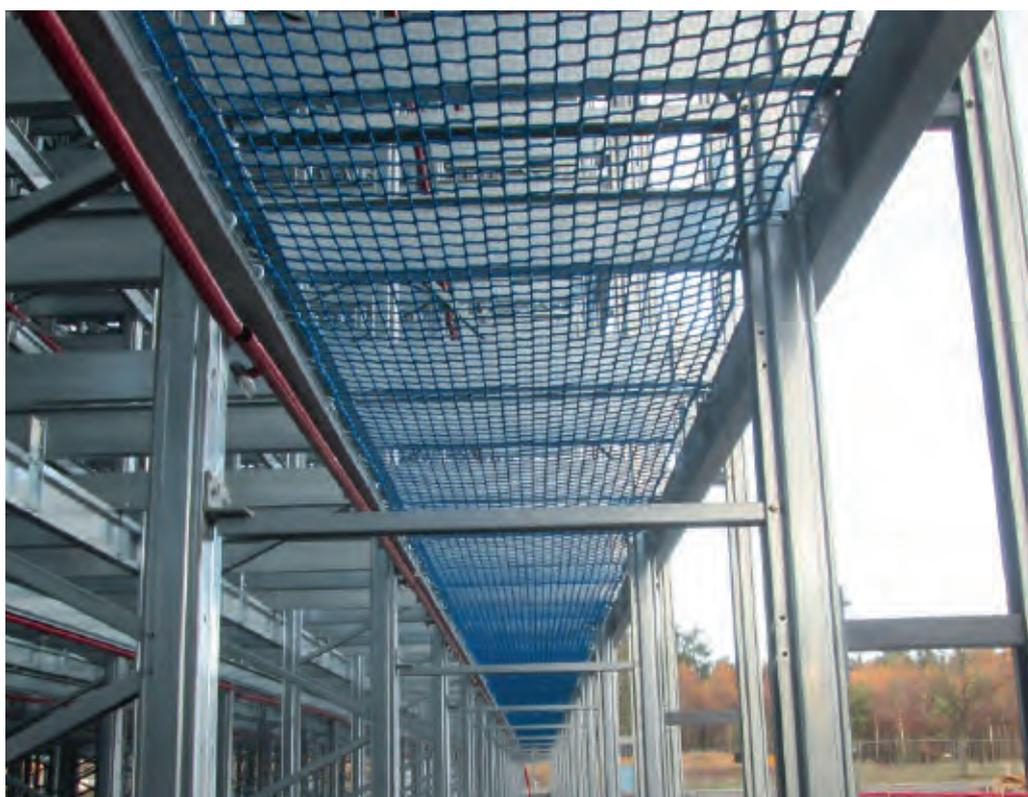
L'utilisation d'un filet de sécurité conforme NF EN 1263-1 est établie pour une surface minimale de 35 m<sup>2</sup>. Dans la pratique, il existe de nombreux domaines d'application avec une surface inférieure. Lors de révision de la réglementation, il a été pris en compte de nouvelles spécificités pour les filets de faible surface.
