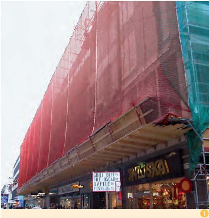
❶ Filet de sécurité garde-corps combiné avec un filet micro-maille antichute objets. Le micro-maille empêche la chute de petits objets et la propagation de poussières. Utilisé dans une zone piétonne.
