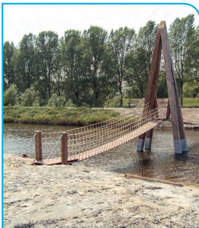
HUCK Torimex (Pays-Bas) Pont à lattes en 2 parties (25.70 m et 11.30 m) avec piliers bois intermédiaires
