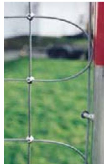
Détail du montage anti-vol par câble transfilé
