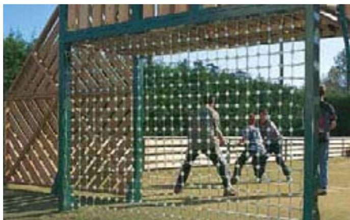
En comparaison aux grillages et treillis métalliques, les filets avec âme acier réduisent les nuisances sonores lors des impacts de ballon.
