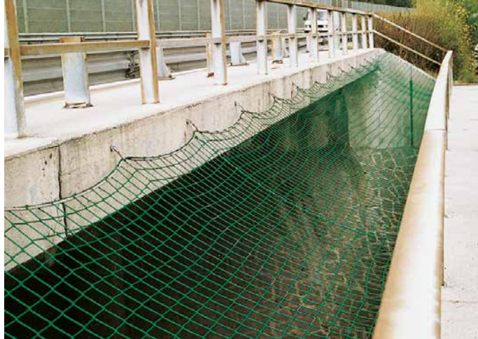
Filet de sécurité sur un pont
