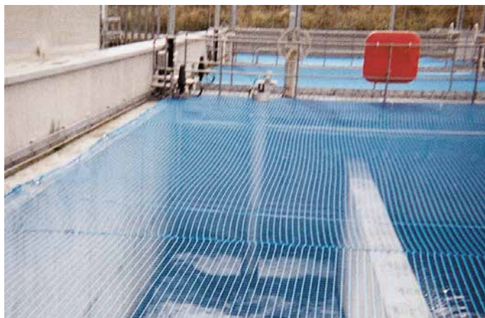
Filet de sécurité sur un bassin d'épuration
