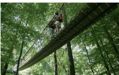
Passerelle à lattes de bois et garde-corps en câble Hercule, longueur 40 m
