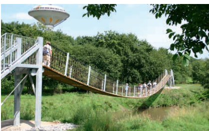
Passerelle à lattes de bois et garde-corps en câble Hercule, longueur 54 m
