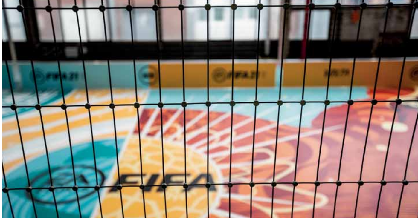
Filet anti-vandalisme en câble acier plastifié \varnothing 1.8/2.5 mm (voir en page 10.8). Collaboration avec la société FUNTEC.
