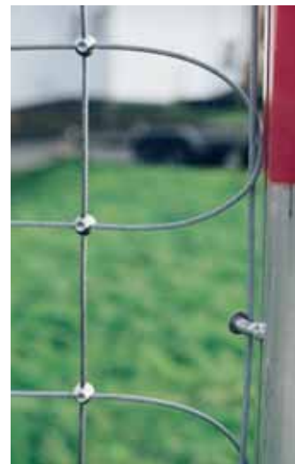
Détail du montage anti-vol par câble transféré
