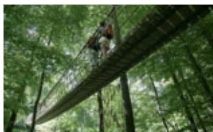
Passerelle à lattes de bois et garde-corps en câble Hercule, longueur 40 m
