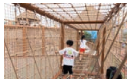
Tunnel en câble Hercule avec parcours ludique (échelons suspendus), longueur 8 m
