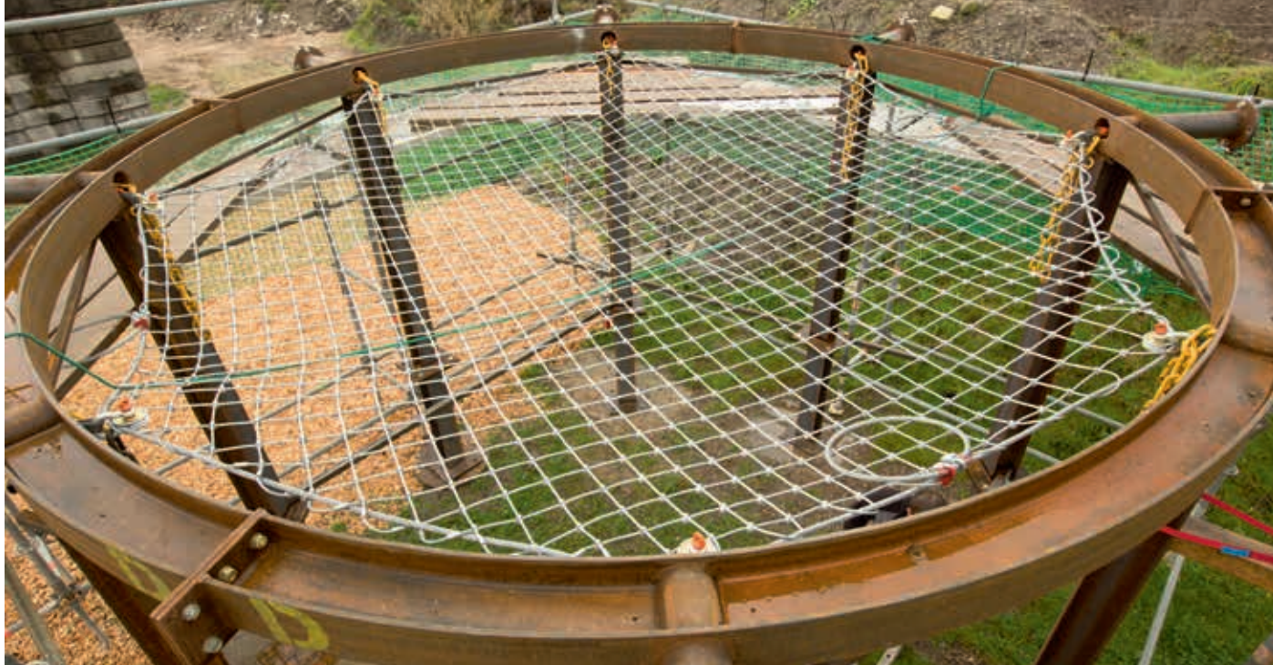
Filet en câble acier « Dralo Xtreme » monté sur structure porteuse circulaire
