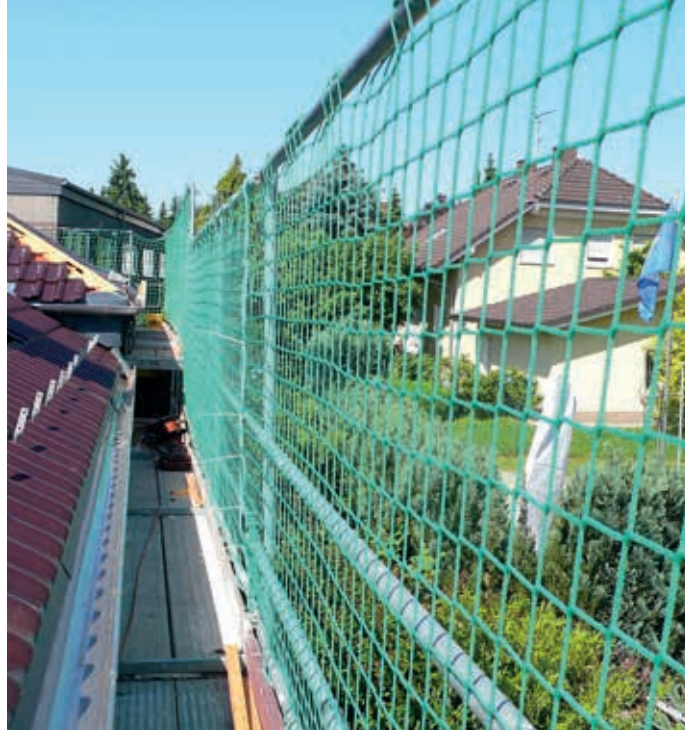
Filets garde-corps avec tubes transfilés dans les mailles
