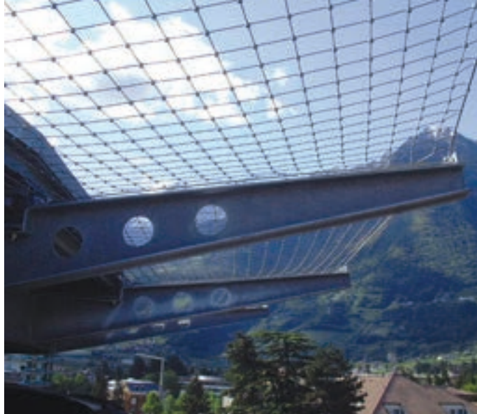
Dralo® utilisé comme dispositif de sécurité extérieure pour un hélicoptère sur un hôpital à Merano.
