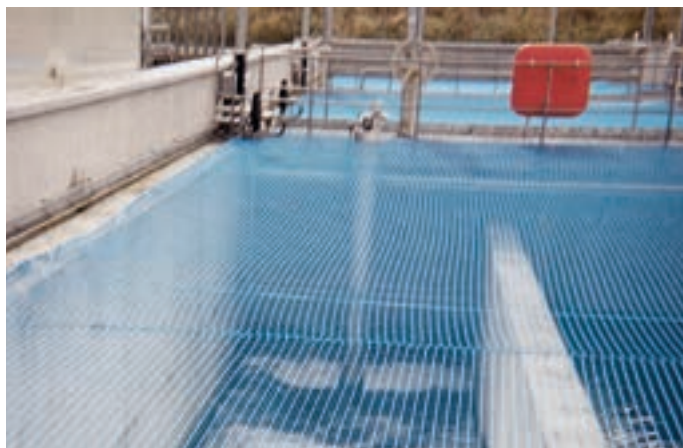
Filet de sécurité sur un bassin d'épuration
