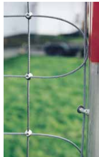
Détail du montage anti-vol par câble transfilé
