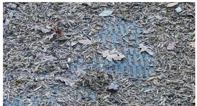
Tapis à maillons installé (mis à nu pour la photo)
