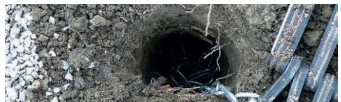
Petit trou dans le sol pour chaînes d'ancrage + fondation (Ø 5 cm)
