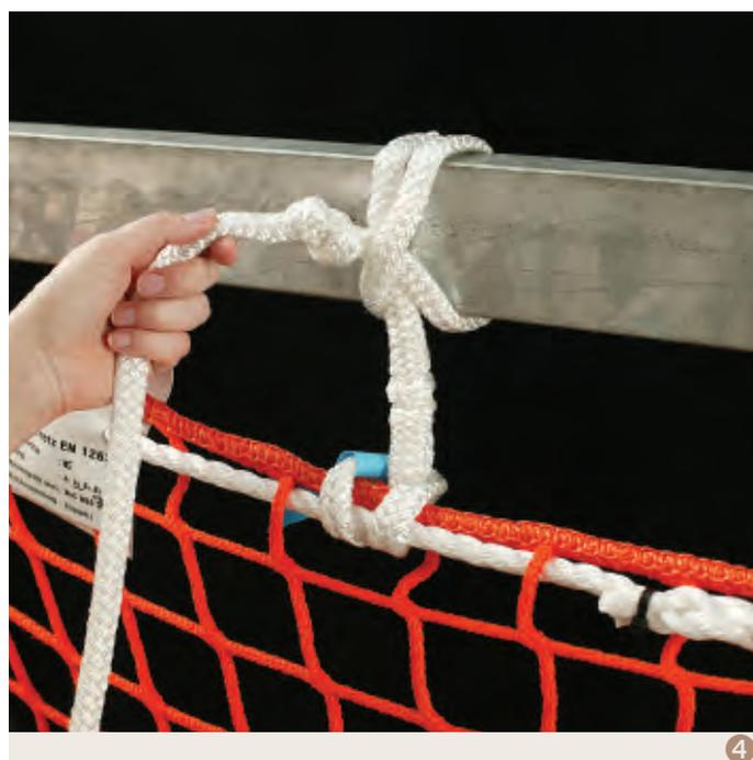
D'une manière générale, les filets antichute de personnes sont fixés à l'aide de cordes d'attache. Suivant la norme EN 1263-1, elles peuvent être munies de boucles d'extrémité ou non. L'ouverture à plat de cette boucle doit être de 150 mm au minimum.
